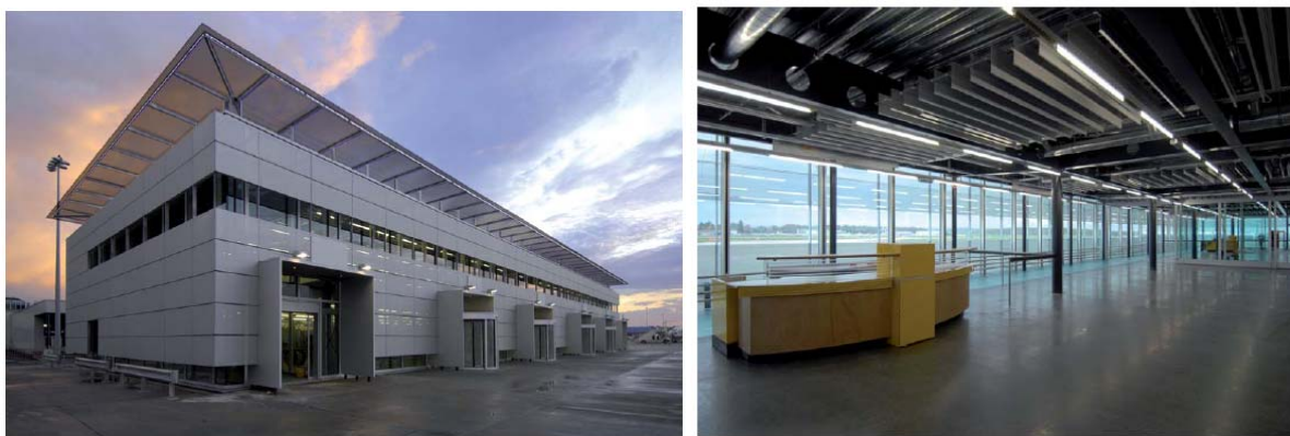
Image de l'extérieur et de l'intérieur de bâtiment Satellite 10 (2008)
